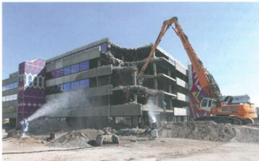
Abb. 1.11: Einsatz von Staubbindemaschinen (Quelle: Ettengruber GmbH Abbruch und Tiefbau, Dachau)
