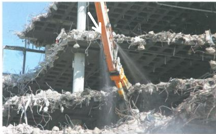
Abb. 1.10: Wasser-sprüheinrichtung am Ausleger (Quelle: Ettengruber GmbH Abbruch und Tiefbau, Dachau)
